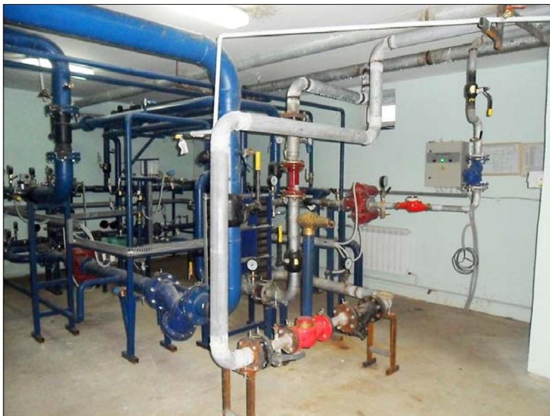
Также в 2014 г. в 141 жилом доме установлены узлы погодного регулирования тепловой энергии по программе капитального ремонта.
