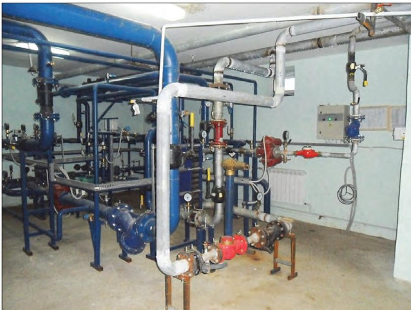
Также в 2015 г. в 14 жилых домах установлены узлы погодного регулирования тепловой энергии по программе капитального ремонта.
