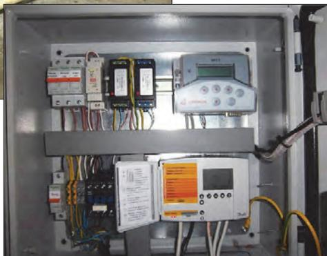
Все устанавливаемые узлы погодного регулирования оснащаются современным оборудованием, узлы учета оснащаются электронными вычислителями, которые обеспечивают контроль за суточным и почасовым потреблением энергоресурсов и воды. Данные узлы сдаются на коммерческий учет и расчет с ресурсоснабжающими организациями производится по фактическому потреблению.
