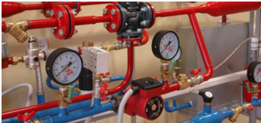
Все устанавливаемые узлы погодного регулирования оснащаются современным оборудованием, узлы учета оснащаются электронными вычислителями, которые обеспечивают контроль за суточным и почасовым потреблением энергоресурсов и воды. Данные узлы сдаются на коммерческий учет и расчет с ресурсоснабжающими организациями производится по фактическому потреблению.
